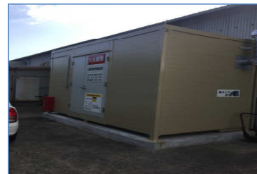
少量危険物倉庫
