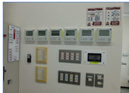
照明・空調機ルール
